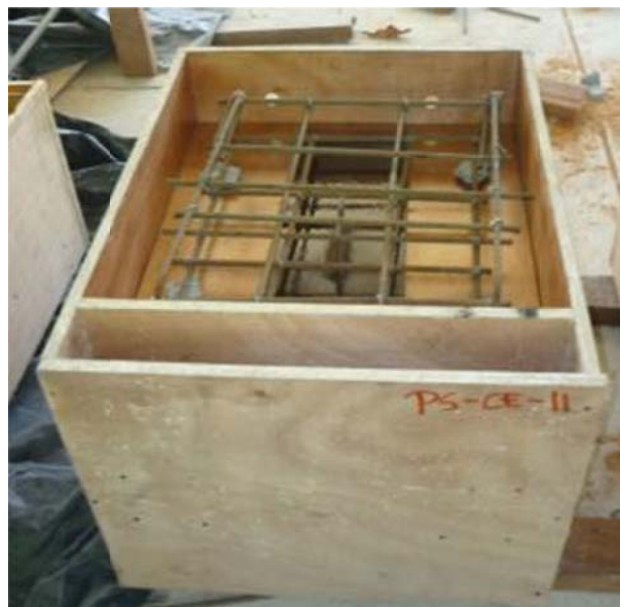
Figura 2. Especimen listo para el vaciado (Incluye colocación de refuerzo, calzas para el recubrimiento).
